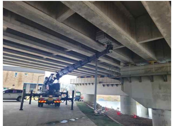
고소작업차를 이용한 근접조사
