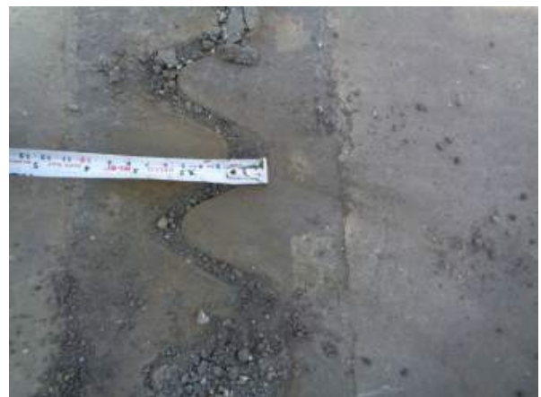
신축이음 이동량 측정
