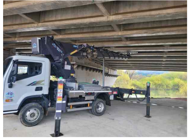
고소작업차를 이용한 근접조사
