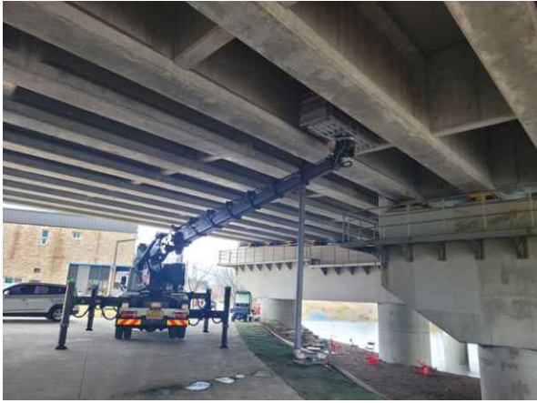
고소작업차를 이용한 근접조사
