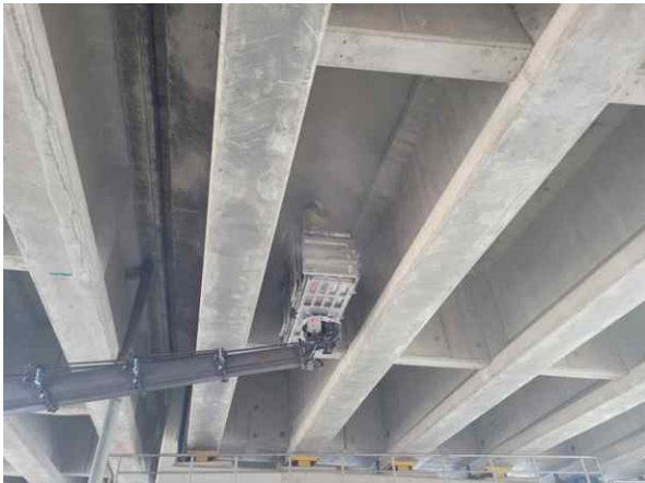
고소작업차를 이용한 근접조사
