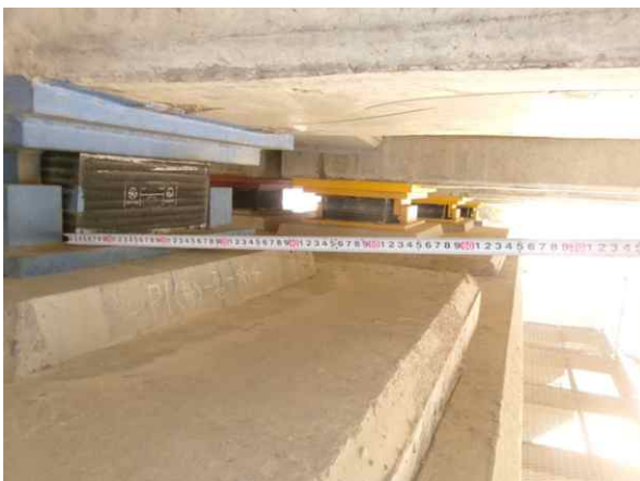
받침장치 연단거리 측정
